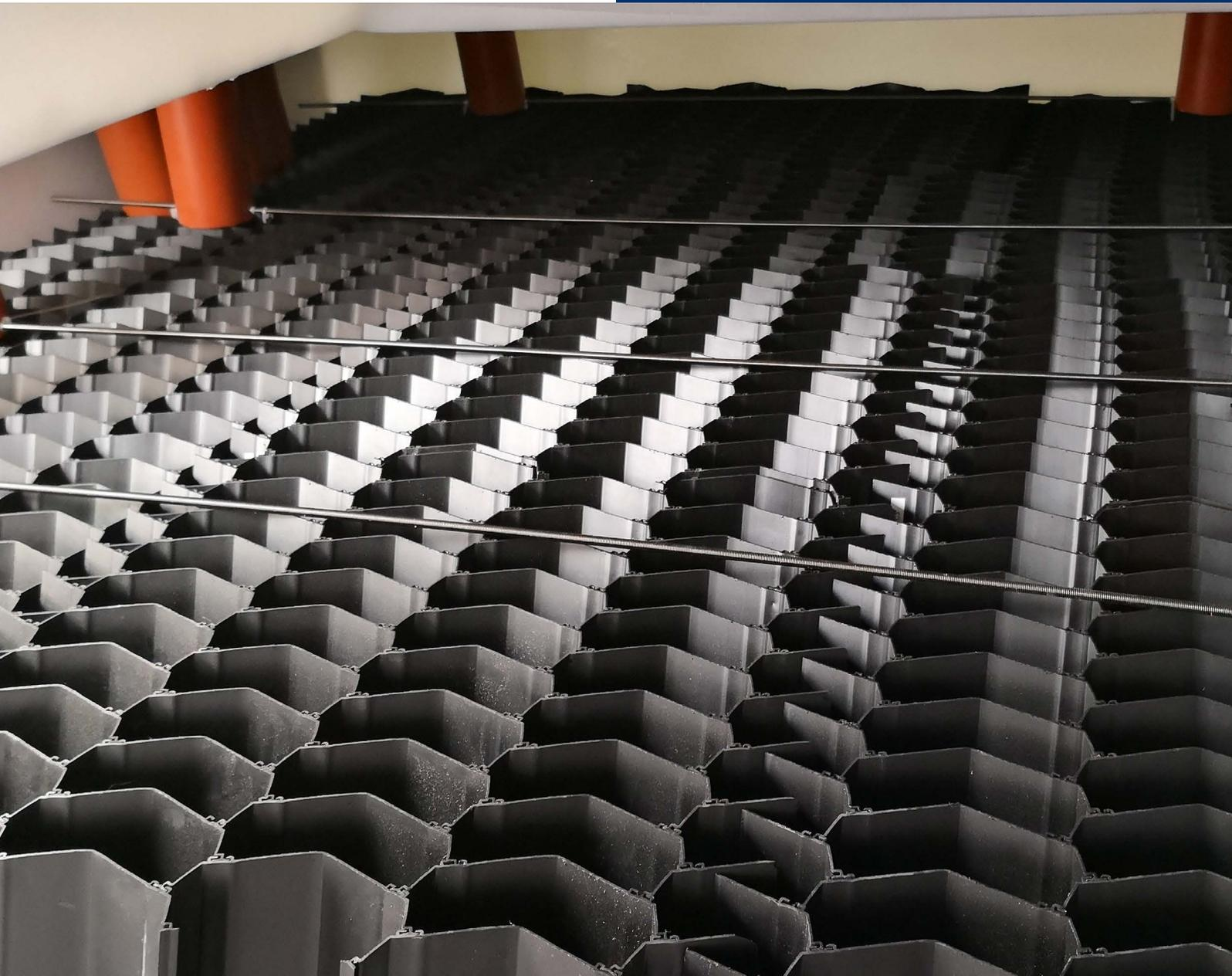
Der ClearFox® Lamellenschrägklärer ist ein Verfahren zur Trennung von Feststoffen und Flüssigkeiten. Er kommt hauptsächlich nach der biologischen Behandlung zur Abtrennung des Schlammes zum Einsatz.
